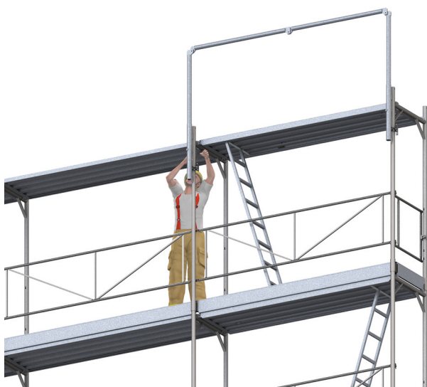
Figur 14: Montering med skydd av MSG på åtkomstfacket.
